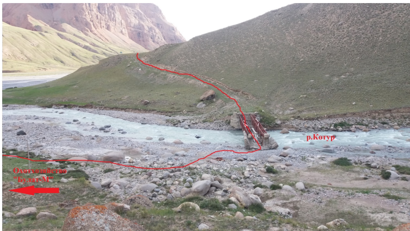
Фото 36. Мост через р. Котур
