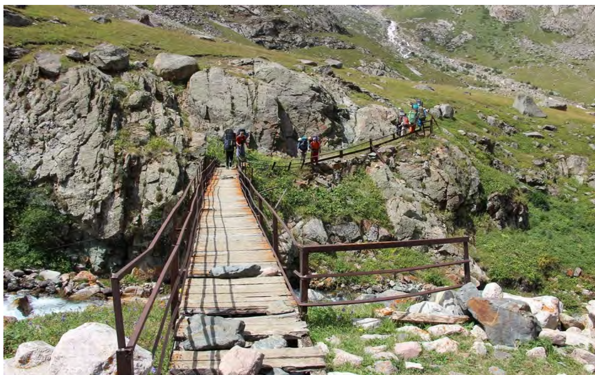
Фото 02-04 Мост через р. Ашутор
