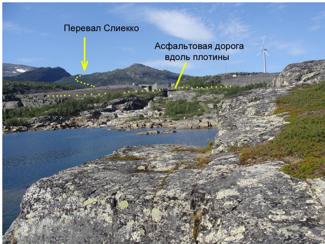
Фото 77. Ветряк на плотине.
