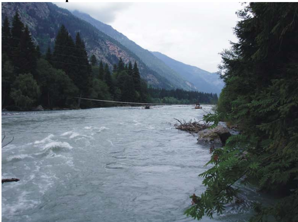
Фото № 1. Мост через р. Теберда в районе впадения р.Хаджибей.
