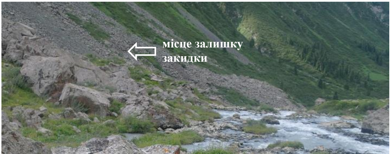
Фото 1.6 – Місце залишку закидки
