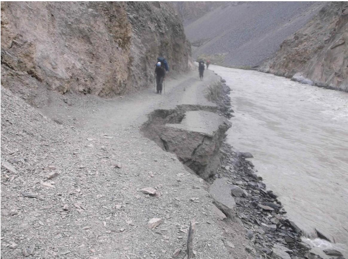
Фото №140. Разрушенные участки дороги на реке Бартанг.
