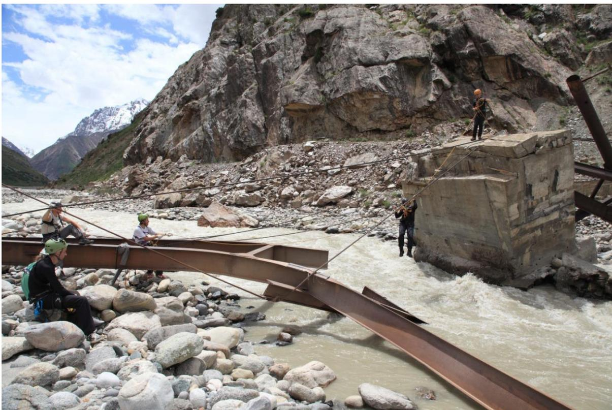
Фото №1. Организация переправы, через разрушенный мост реки Абдукагор.
