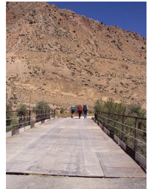
Фото 82 – Мост через р. Сарытаг
