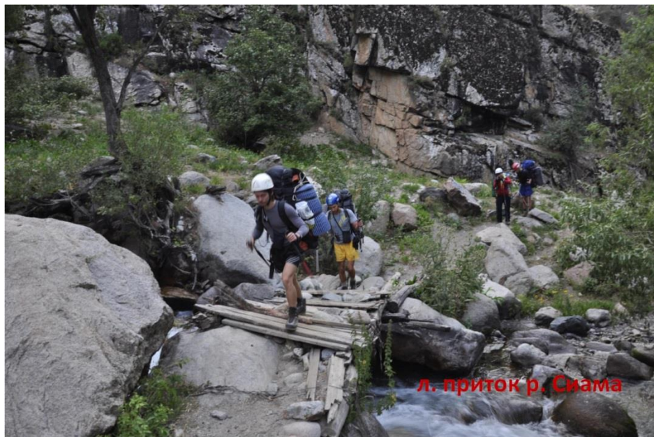
Фото 5 – Мост через левый приток р. Сиама
