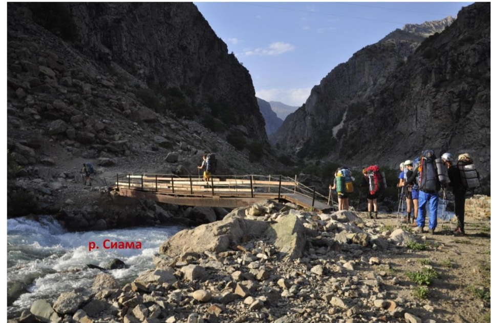
Фото 2 – Мост через реку Сиам
