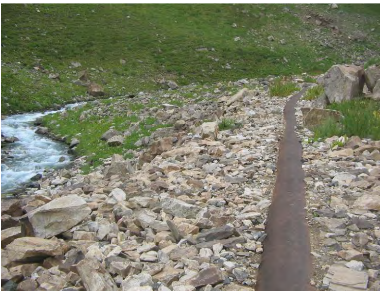
Рис.24. Труба водозабора р.Якарча
