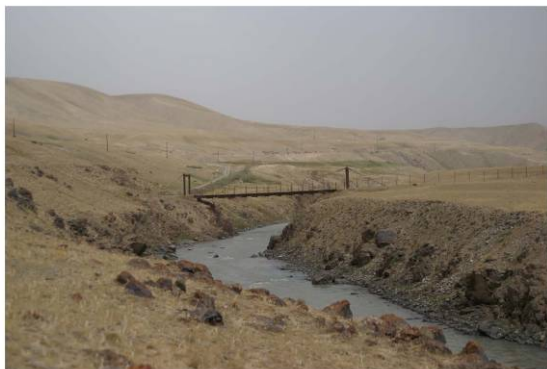
Рис.3.3.5.17. Мост через р.Коксу около границы с КНР
