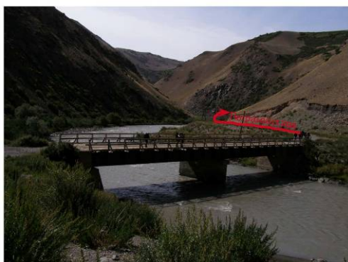
Рис.3.3.6.8. Мост через р.Коксу
