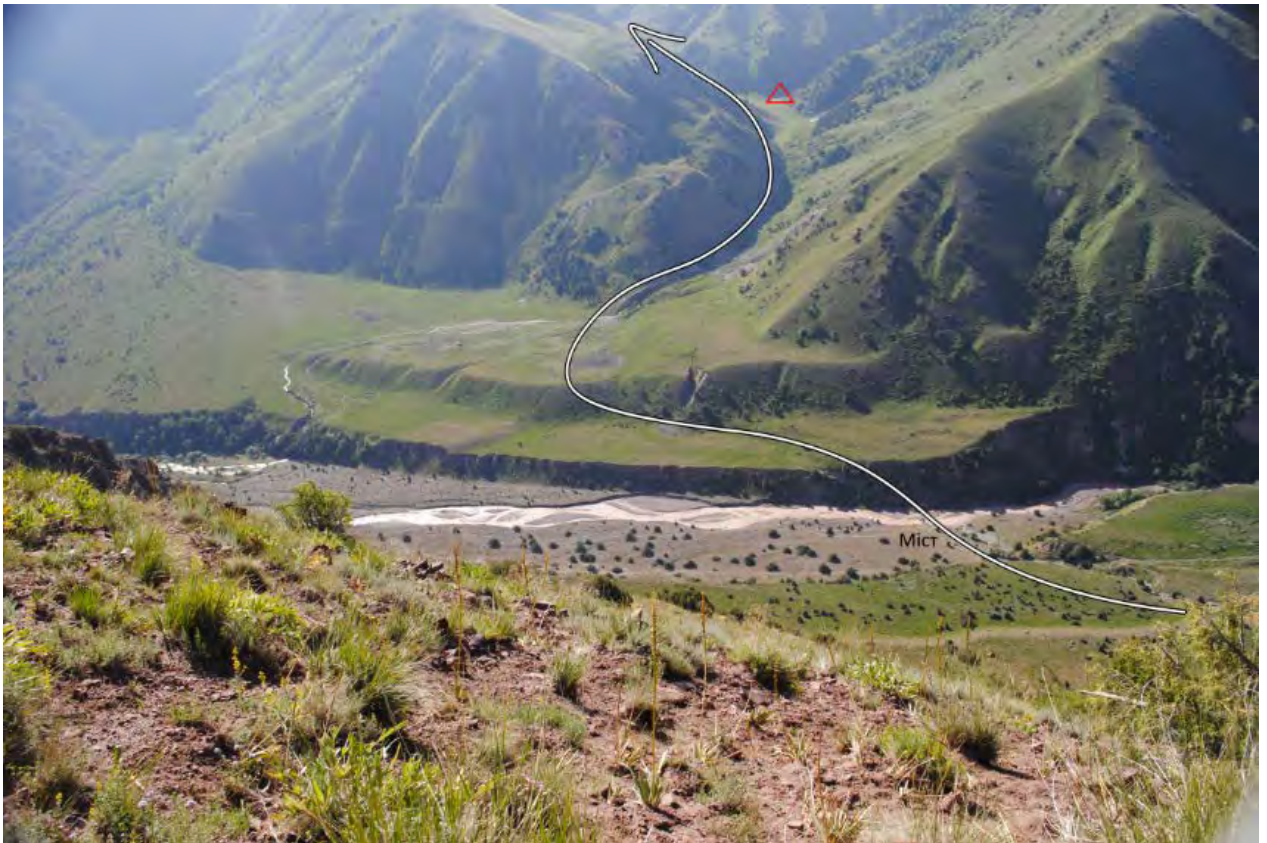
Фото 19. Зруйнований міст в д.р. Кель-Дук
