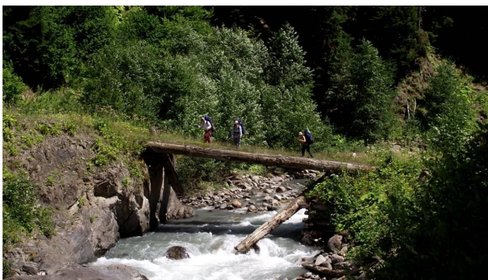
Фото 5. Мост через реку Хумирула
