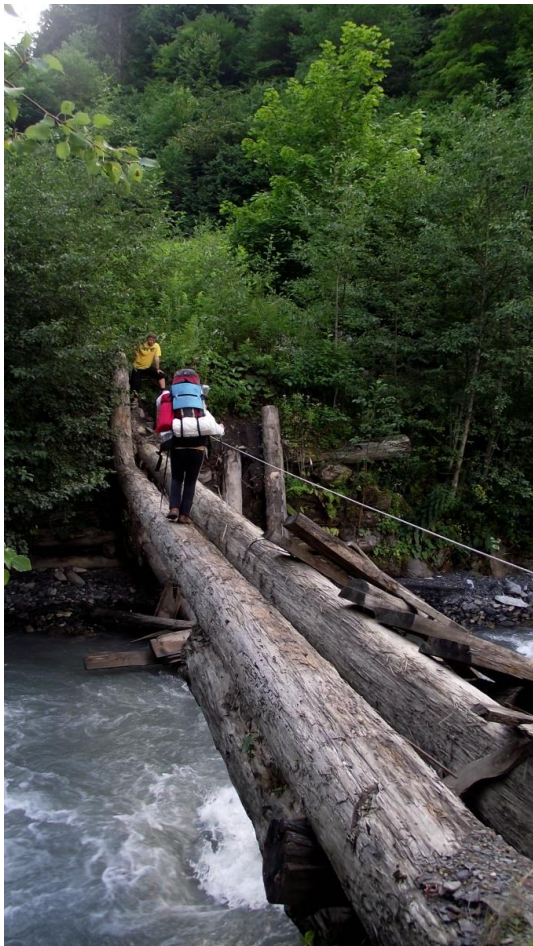
Фото 2. Переправа по размытому мосту
