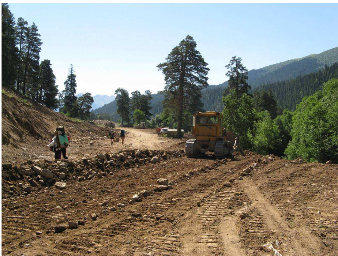
Фото 107 – Движение группы по долине р. Архыз, ведутся строительные работы
