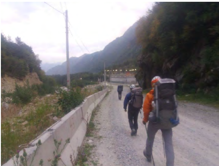
Рисунок 187. Гидротехническое сооружение непонятного назначения за один переход до финиша.
