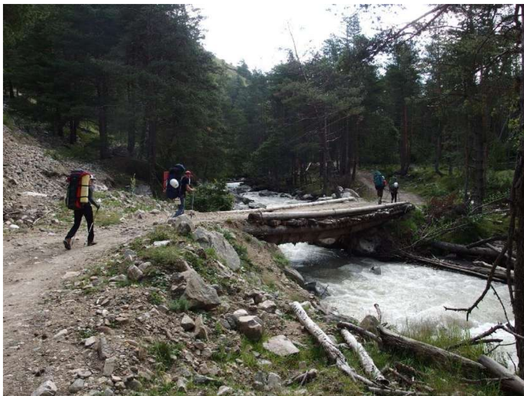
Ф.8. Проходим очередной мост через реку Битюктебекол.
