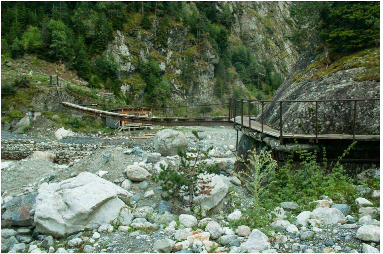
Фото 24 – Мост через реку Местичала
