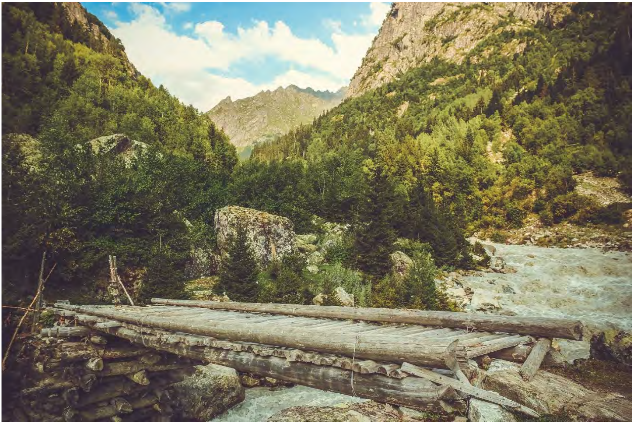
Фото 61 – Мост через реку Цаннер
