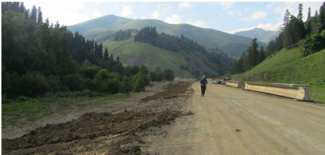
Рисунок 122 – Балки нового автомобильного моста через р. Архыз
