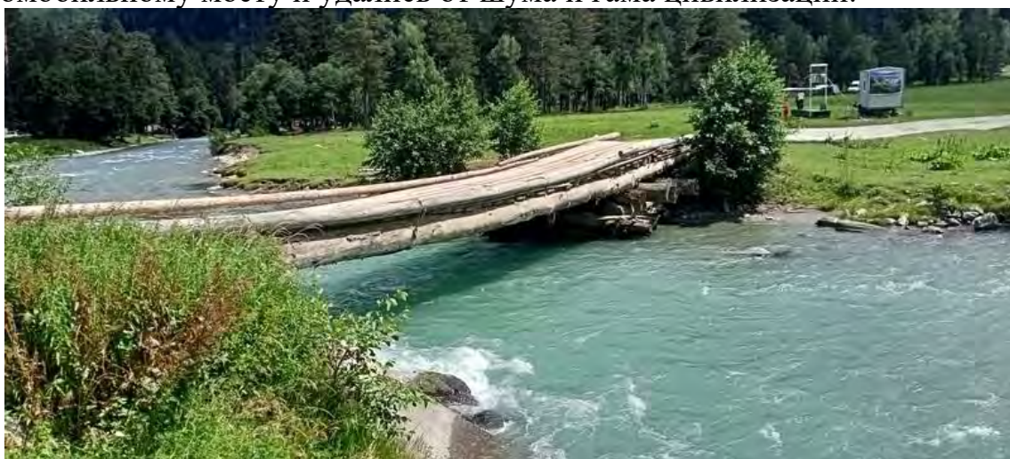
Рисунок 162 – Автомобильный мост через р. Псыш на поляне Таулу
