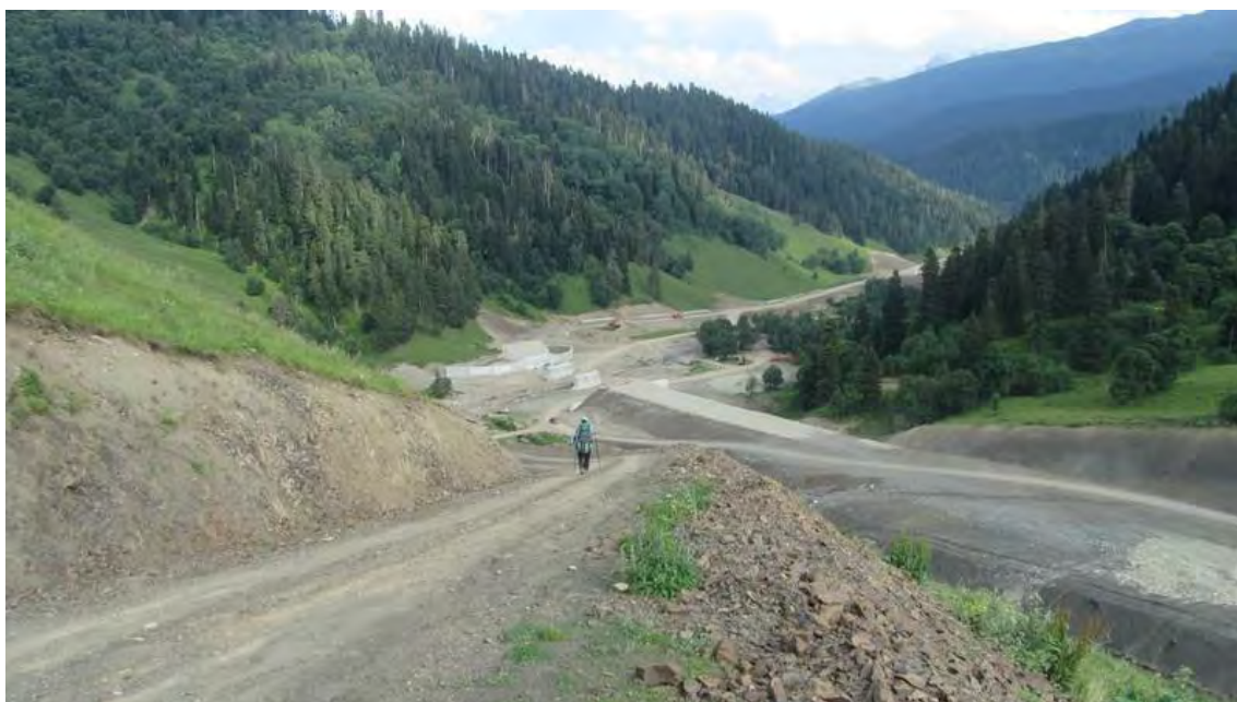
Рисунок 120 – Выход к стройке новой дороги на п. Пхия
