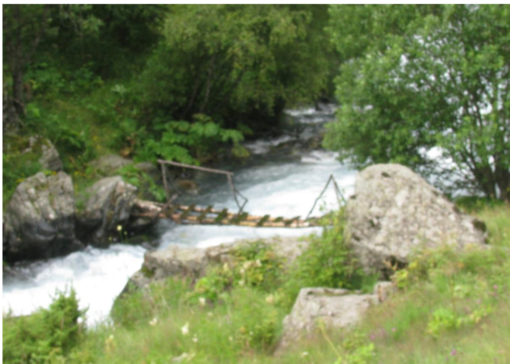
Фото 57. Мост через р. Кистинка
