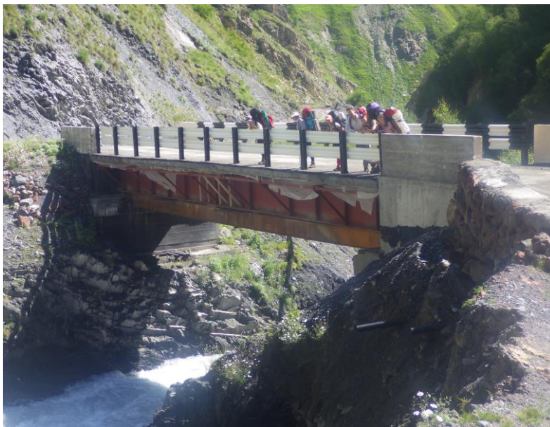
Фото 27. Мост через Терек в ущелье
