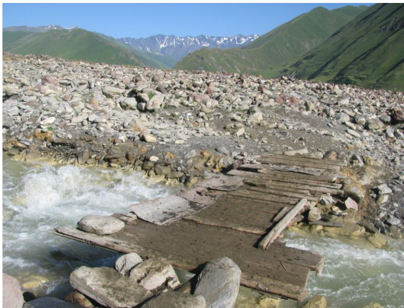
Фото 25. Мост через р. Эси, в метрах 500 до слияния с Тереком
