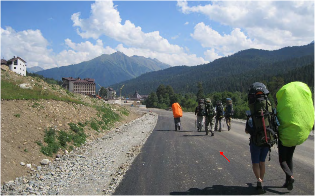
Фото 47. Будівництво гірськолижного комплексу у долині Архиза.
