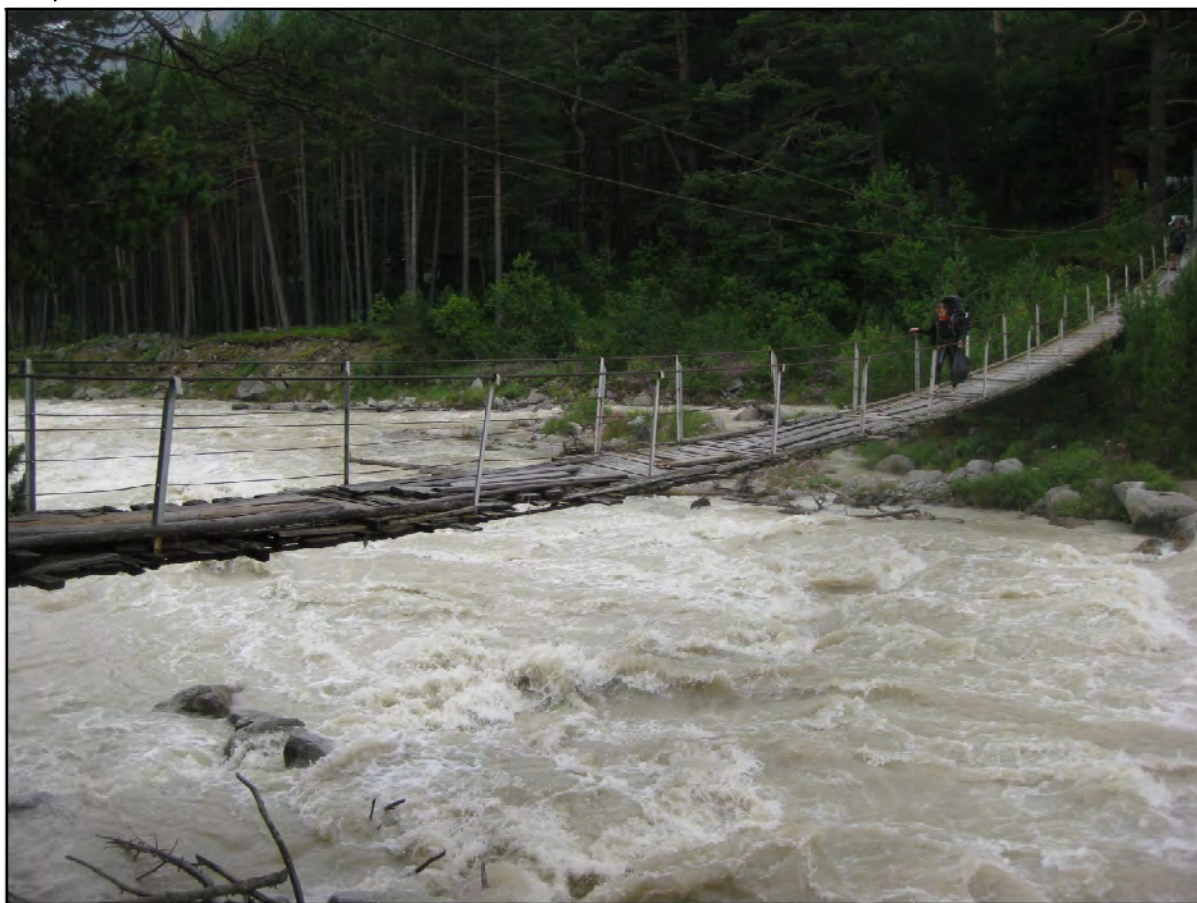
Рис. 11 - Подвесной мост через реку Башиль-Аузсу.
