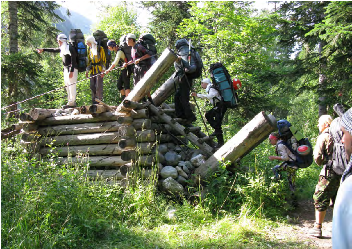
Фото 84. Опора мосту на правому березі Псиша.
