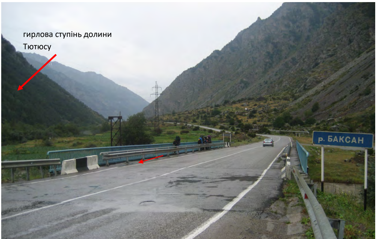
Фото 33. Мост перед злиттям Баксана і Тютюсу.
