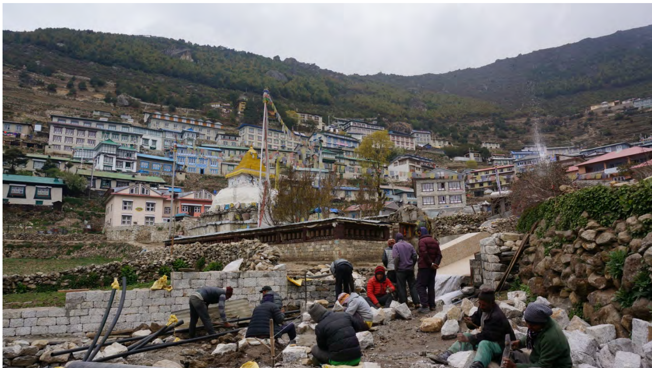
Фото 64. Намче Базар (3440 м) місцеві будівельники
