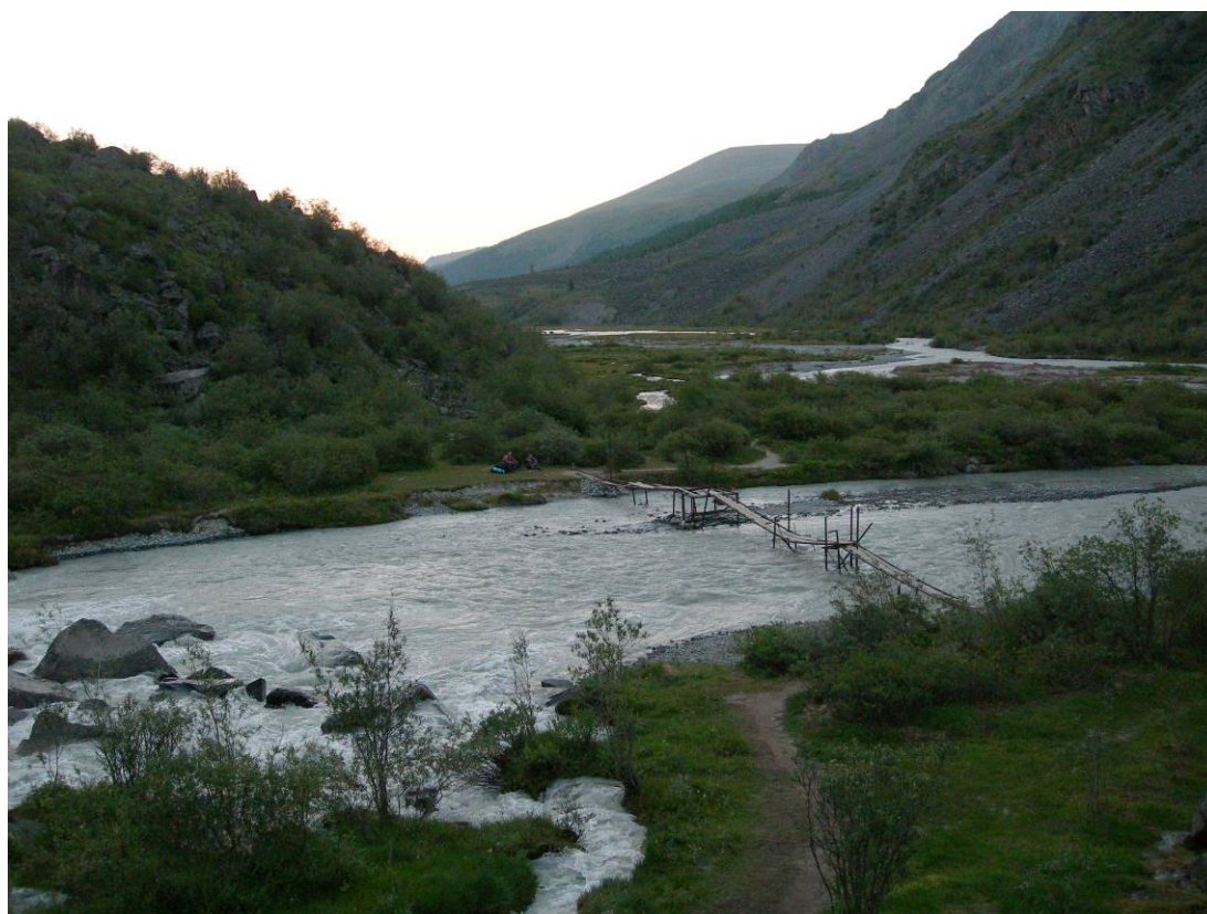
Фото 63. Мост через Аккем
