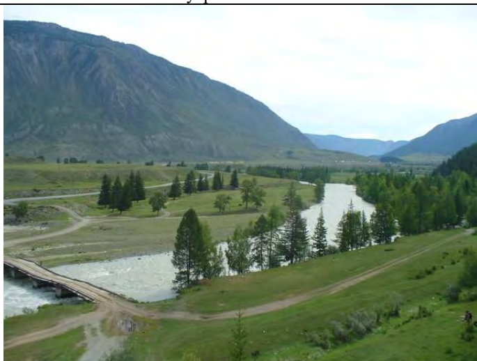
Фото 5 – Мост через р. Чуя ниже пос. Чибит
