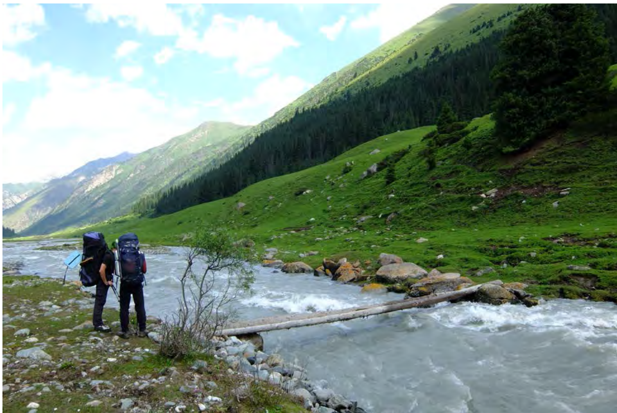
Фото 3.1.5 – Мост через р. Арашан
