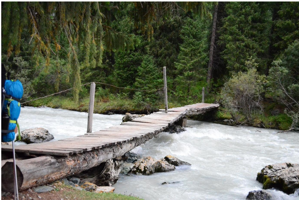
Мост через р. Каракол, на сторону ущелья Ала- Кёль
