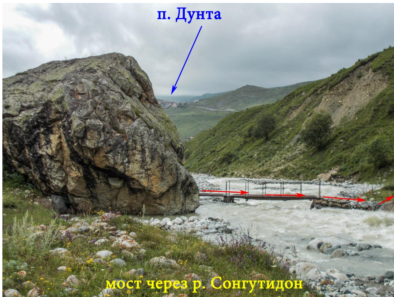
Фото 86 Мост через реку Сонгутидон в 2 км от поселка Дунта.
