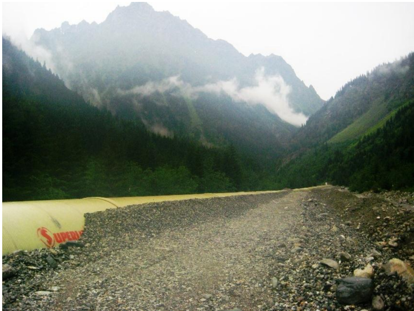
фото 27. Гидротехническое сооружение на р. Местиячала.
