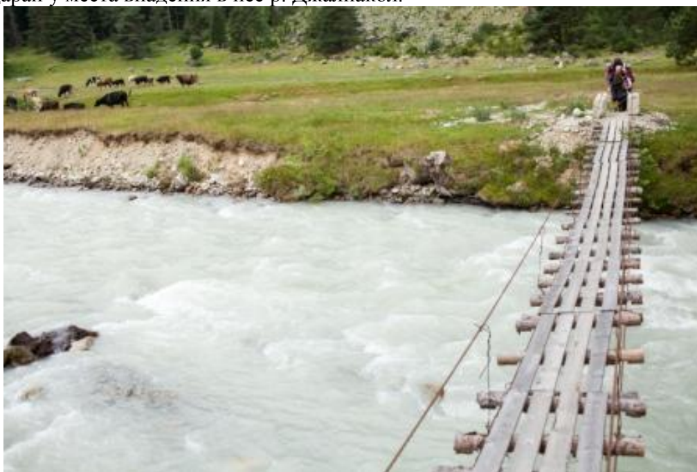
Фото 14. Мост через р. Гондарай.
