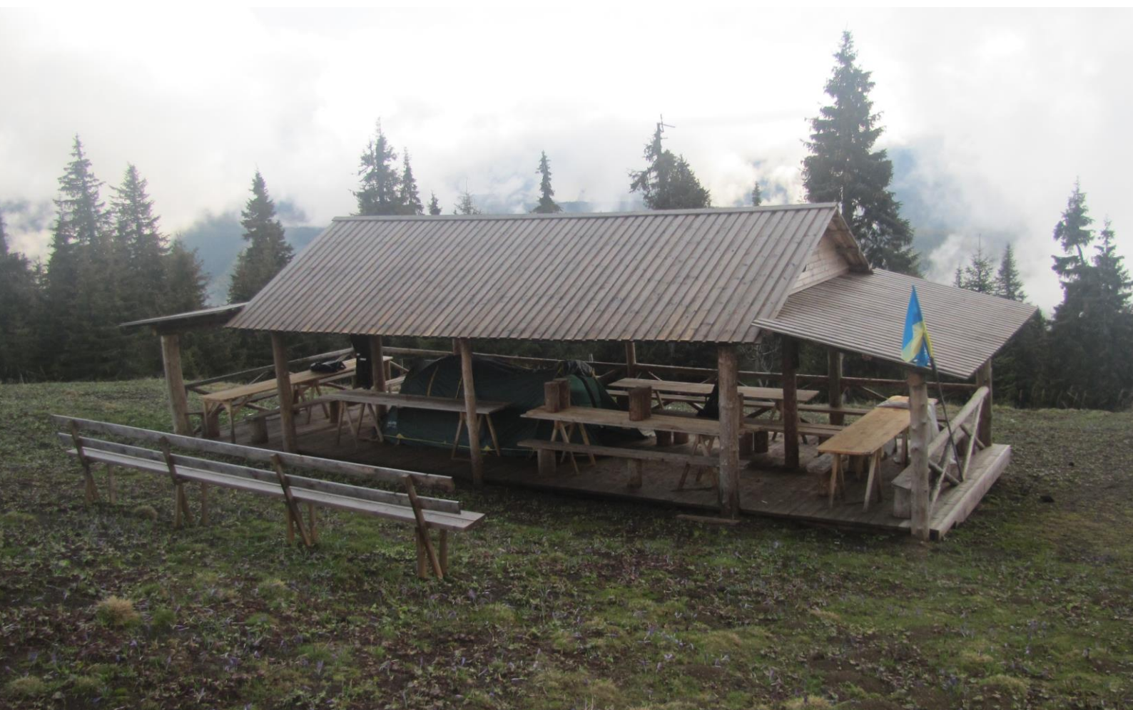
Фото 5.6.2. Місце ночівлі на полонині Лемська.
